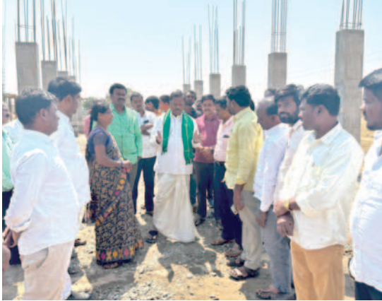
ఆమనగల్లు ప్రభుత్వ జూనియర్ కళాశాల భవన నిర్మాణ పనులను పరిశీలిస్తున్న ఎమ్మెల్యే గుర్రా జైపాల్ యాదవ్
